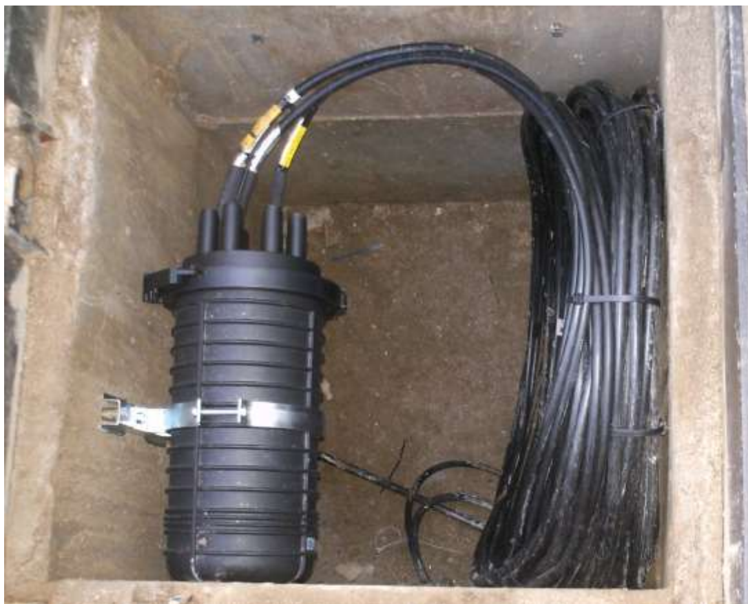
5.12 - Exemplo da instalação de uma junta de fibras óticas do tipo torpedo
